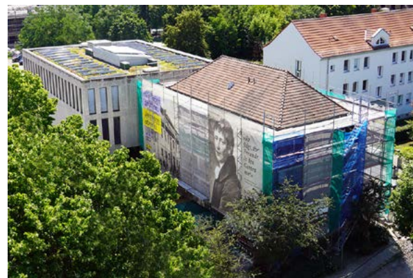
Prace remontowe w starym budynku Kleist-Museum, 2023 ©Stiftung Kleist-Museum
