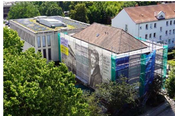
Sanierungsarbeiten am Altbau des Kleist-Museums, 2023 ©Stiftung Kleist-Museum
